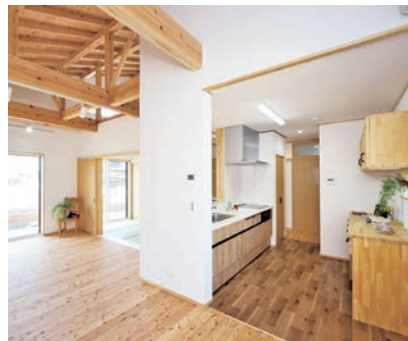
■ 耐久性と居心地に配慮し適材適所に使い分けられた床材
