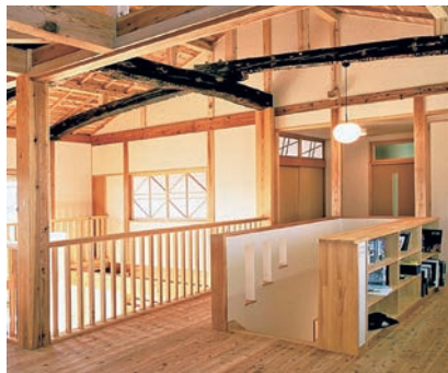
■ 古民家の2階を居住スペースにリノベーション
